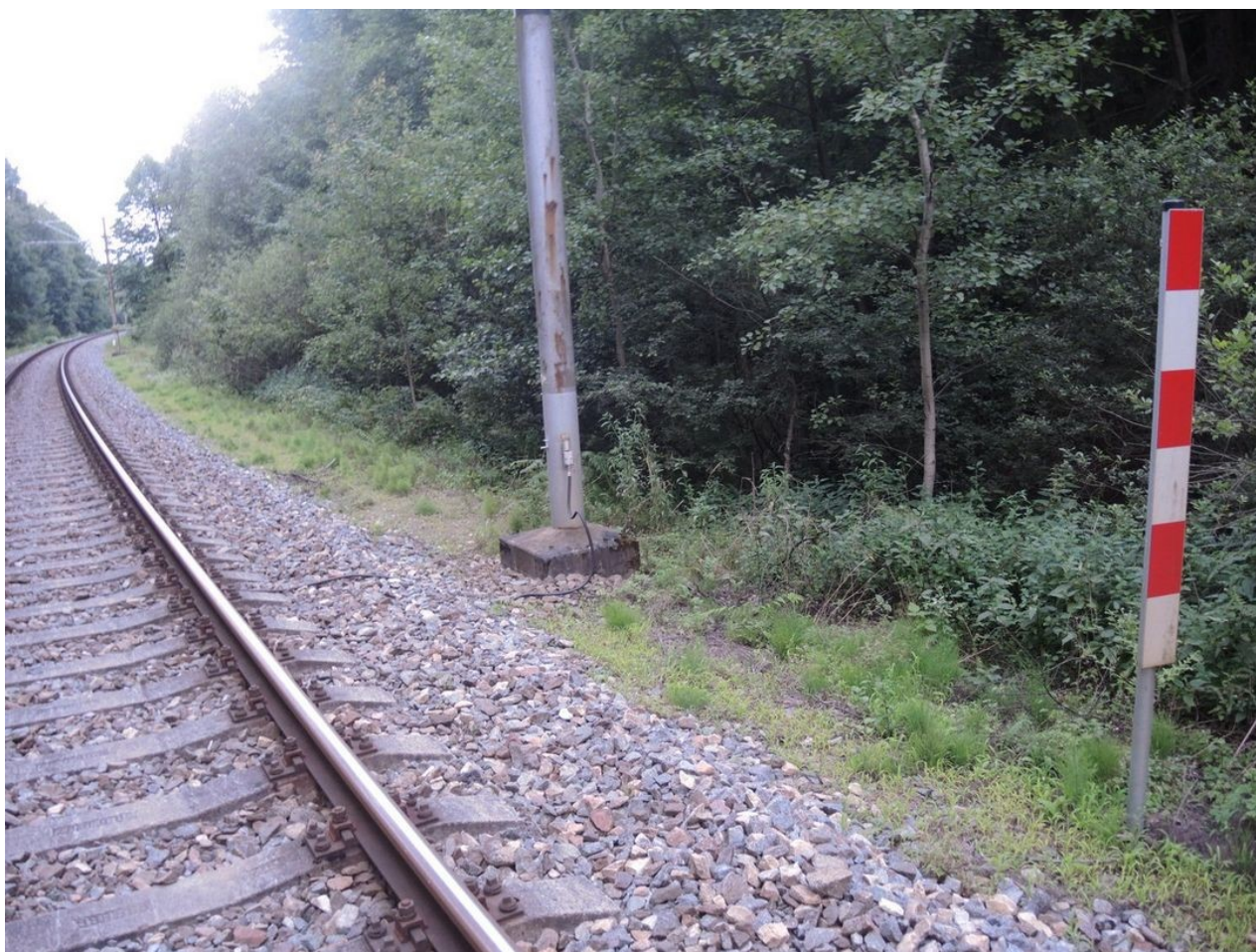
Obr. č. 2: Pohled na výstražné návěstidlo s návěstí „Pískejte“, které bylo umístěno ze směru od železniční stanice Borohrádek 569 m před ŽP P4875
