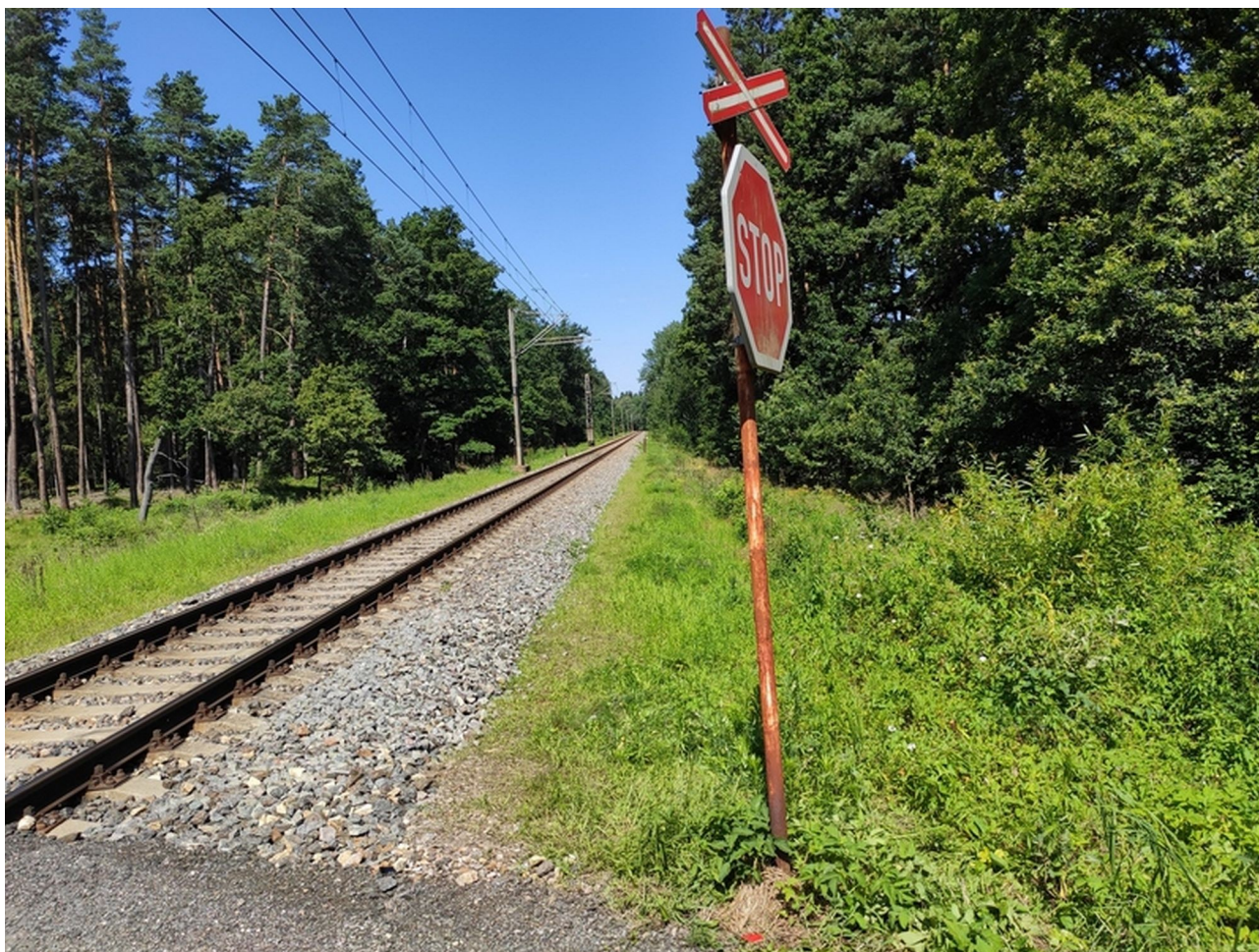
Obr. č. 5: Pohled na dráhu ve směru k žst. Borohrádek (při dodatečném ohledání místa MU)
