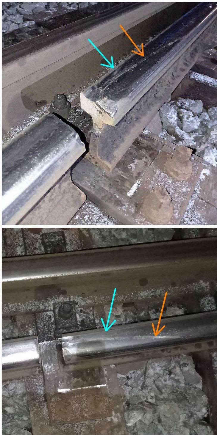
Obr. č. 5: Stav lomových ploch po nakolejení a odtažení DV (vlak jel na fotografiích zleva doprava). Horní polovina lomu se jevila čerstvá, na spodní polovině byla koroze staršího data. Modrou šipkou vyznačena stopa jízdy okolku levého kola 1. dvojkolí po hlavě jazyka, oranžově pak stopa jízdy levého kola 2. dvojkolí, které následně zpětně nakolejilo. Na pojížděné hraně odlomené části jsou zřetelné 4 stopy od nárazu všech levých kol motorové jednotky. Zdroj: SŽ
