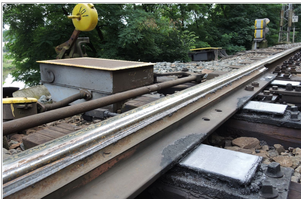
Obr. č. 7: Pohled na pravý jazyk výhybky č. 101 po MU se stopami po kontaktu s okolky kol DV v celé délce od jeho začátku Zdroj: DI
