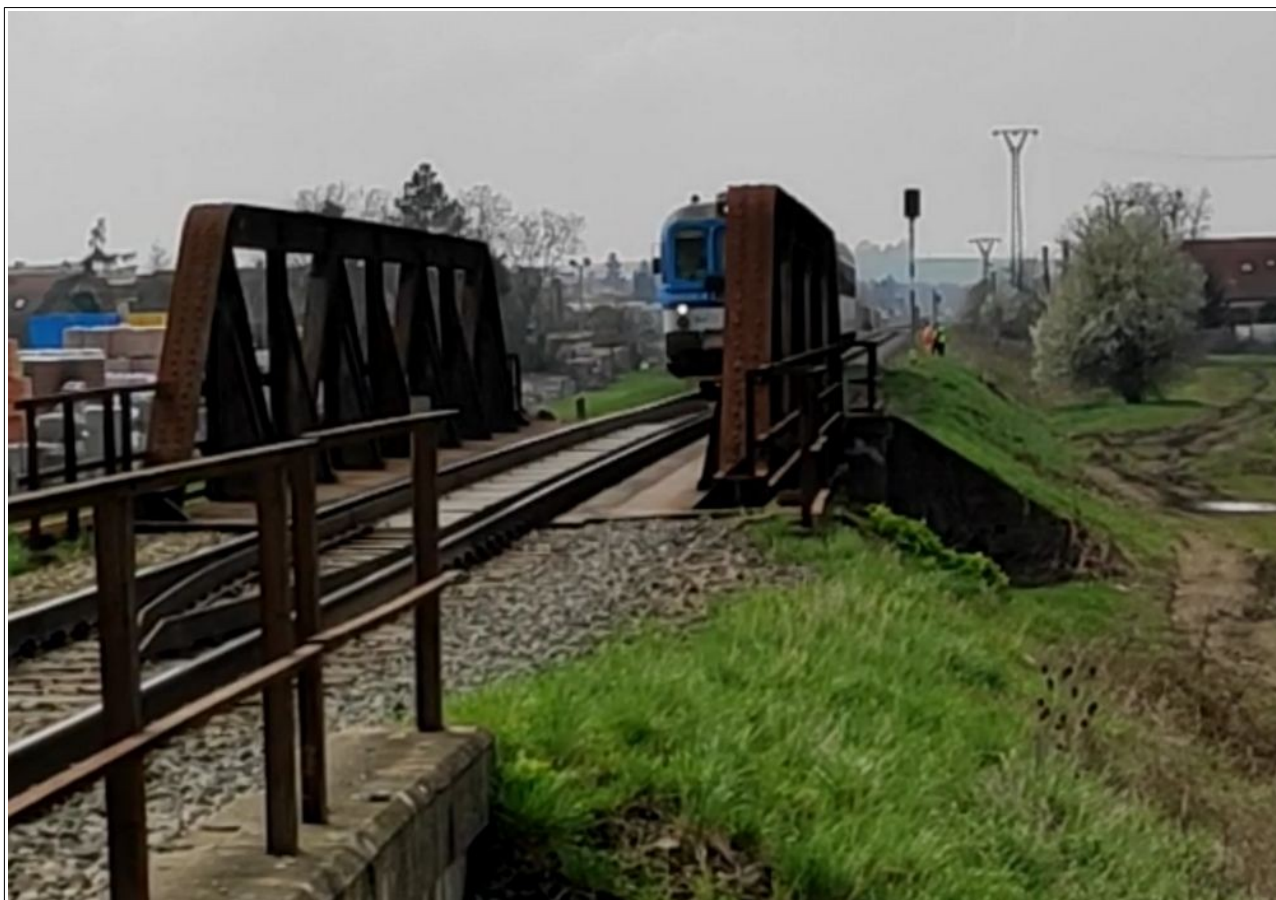
Obr. č. 3: Pohled na trať a přijíždějící DV ze směru od žst. Ostrožská Nová Ves (z úrovně výstražných křížů při dodatečném ohledání místa MU). Zdroj: DI
