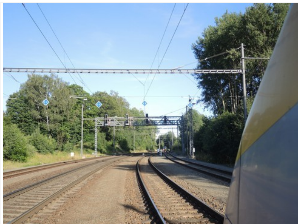
Obr. č. 5: Pohled na odjezdové návěstidlo S1 s následným vykolejením vlaku Os 7004 na výhybkách č. 1 a 2 žst. Lázně Kynžvart Zdroj: DI
