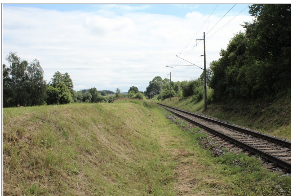
Obr. č. 3: Pohled na trať od úrovně výstražného kříže ze směru jízdy OA proti směru jízdy vlaku Nex 60430.
