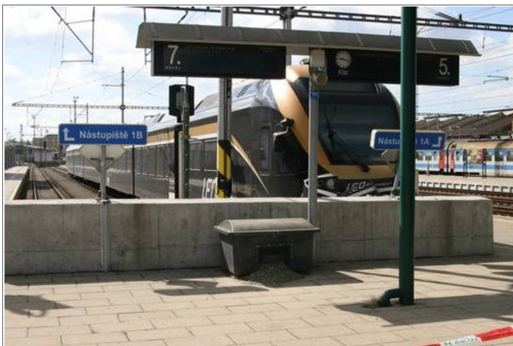
Obr. č. 6: Pohled na místo vzniku MU ve směru od výpravní budovy žst. Přerov.
