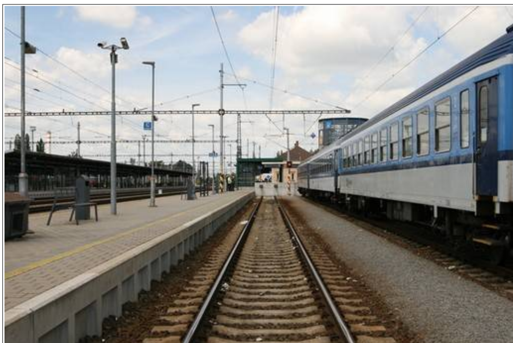
Obr. č. 9: Pohled na hlavní (cestové) návěstidlo Sc5 a betonové zaráždlo na konci SK č. 5 žst. Přerov ze vzdálenosti 71 m.
