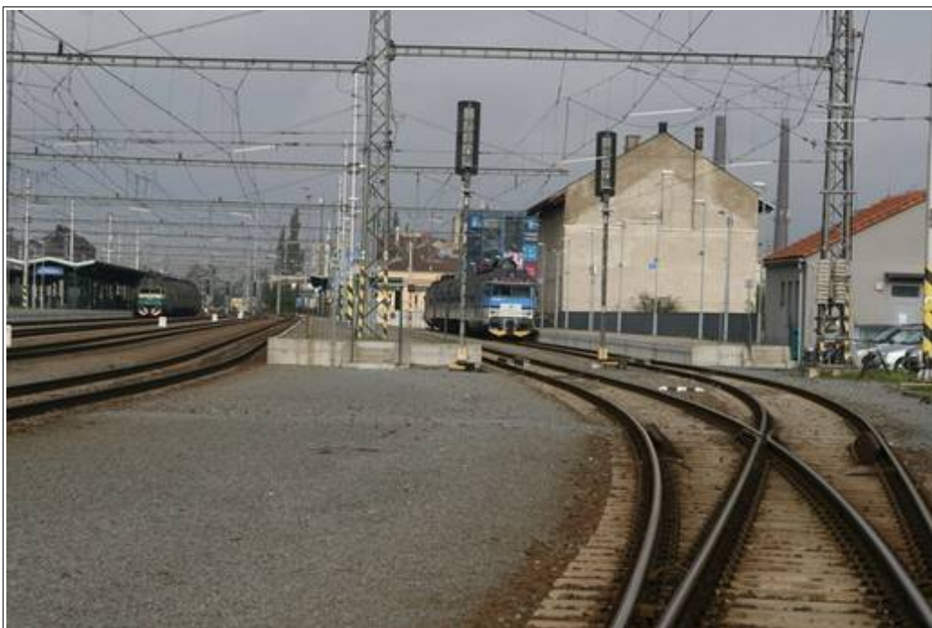
Obr. č. 10: Ničím nerušený výhled na návěst hlavního (cestového) návěstidla Sc5, betonové zarážedlo na konci SK č. 5 a výpravní budovu žst. Přerov.
