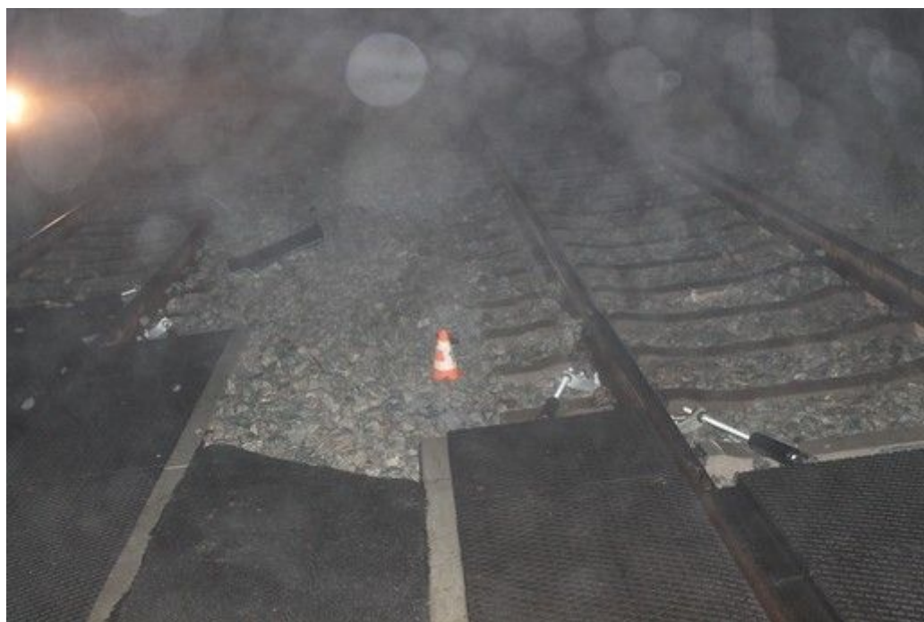
Obr. č. 10: Detailní pohled na místo zapadnutí
