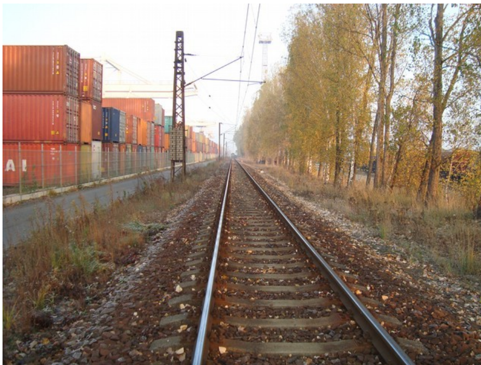
Obr. č. 7: Rovný úsek 90. spojovací koleje před návěstidlem Lc 403
