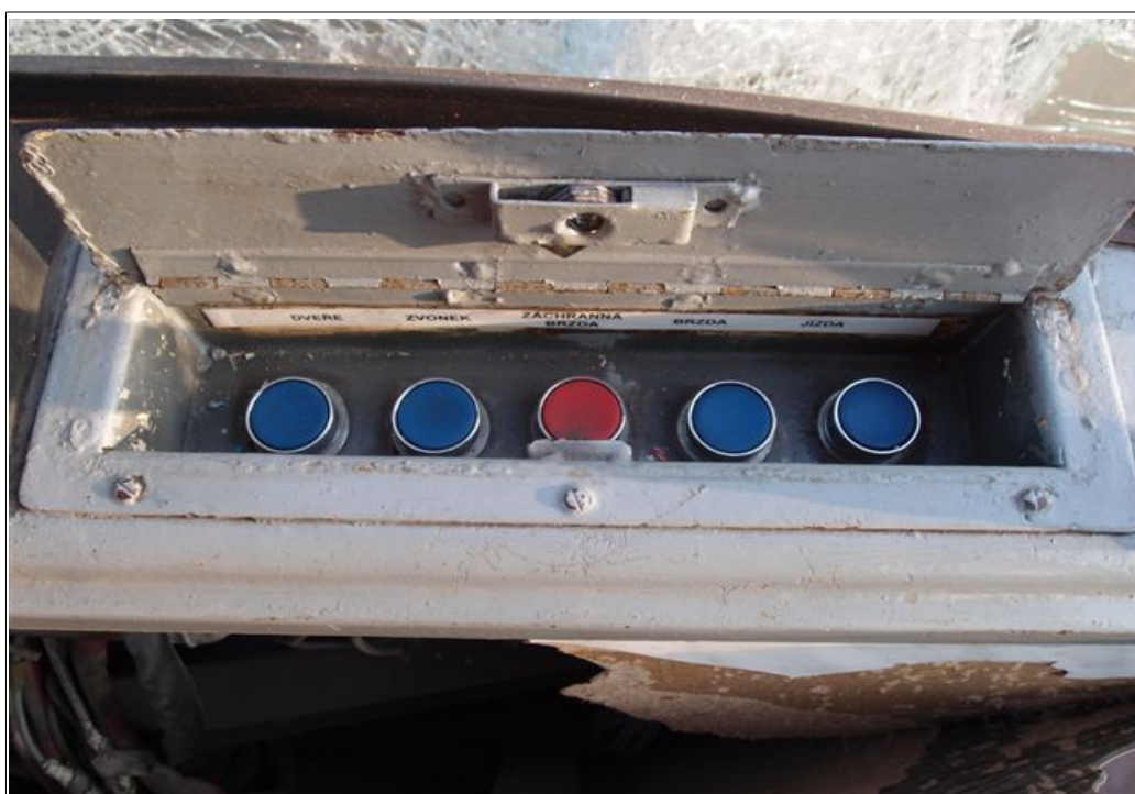
Obr. č. 7: Pohled na panel zadního pomocného stanoviště DV ev. č. 902
