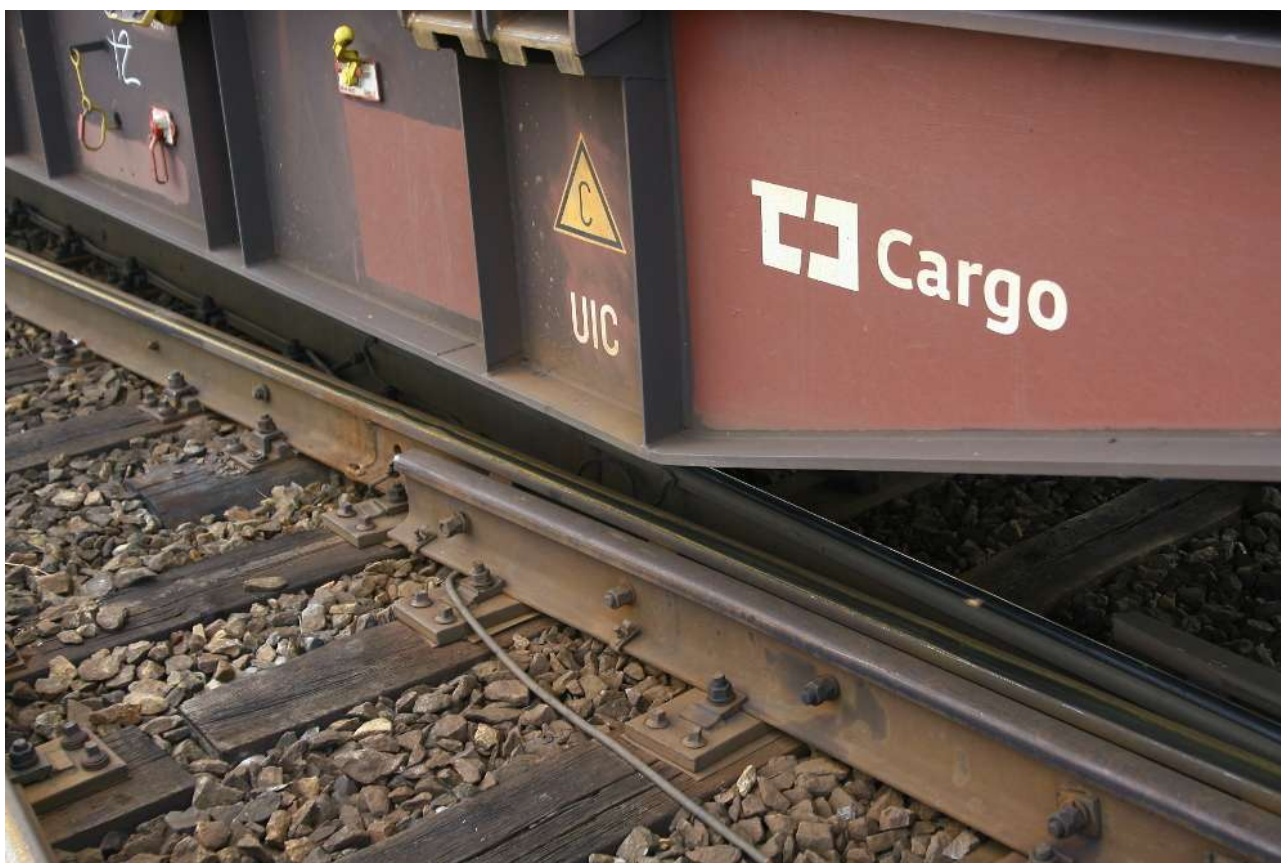
Foto 10: Stopy levého kola na srdcovce výhybky č. 3
