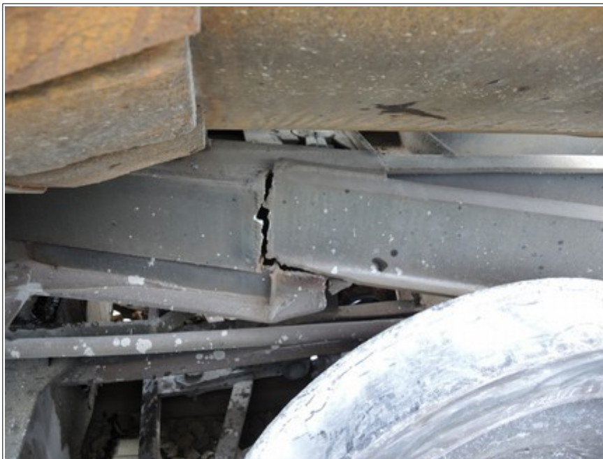
Obr. č. 8: Detailní pohled na místo únavových trhlin (prasklin) levé úhlopříčné výztuhy rámu vozu vykolejeného TDV 33 51 7984 332-1.
