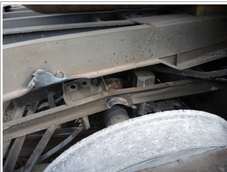
Obr. č. 6: Pohled na vybroušená místa na výztuhách vykolejeného TDV 33 51 7984 332-1.
