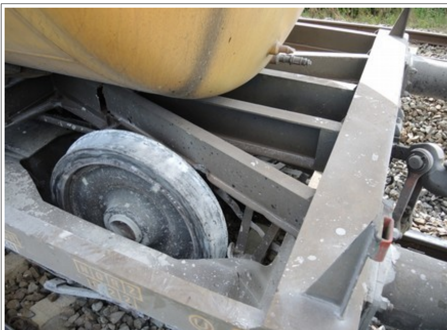
Obr. č. 7: Pohled na zadní nápravu podvozku (b) a v místech únavových trhlin (prasklin) ulomenou levou úhlopříčnou výztuhu rámu vozu vykolejeného TDV 33 51 7984 332-1.
