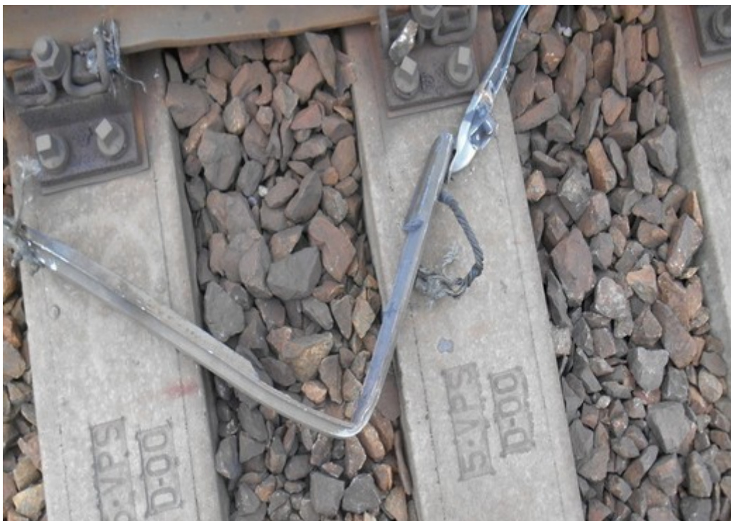
Obr. č. 6: Lišta sběrače č. 1, HDV 362 023-4, první ve směru jízdy vlaku, nalezená v km 118,400 na výhybce č. 25 v žst. Vranovice
