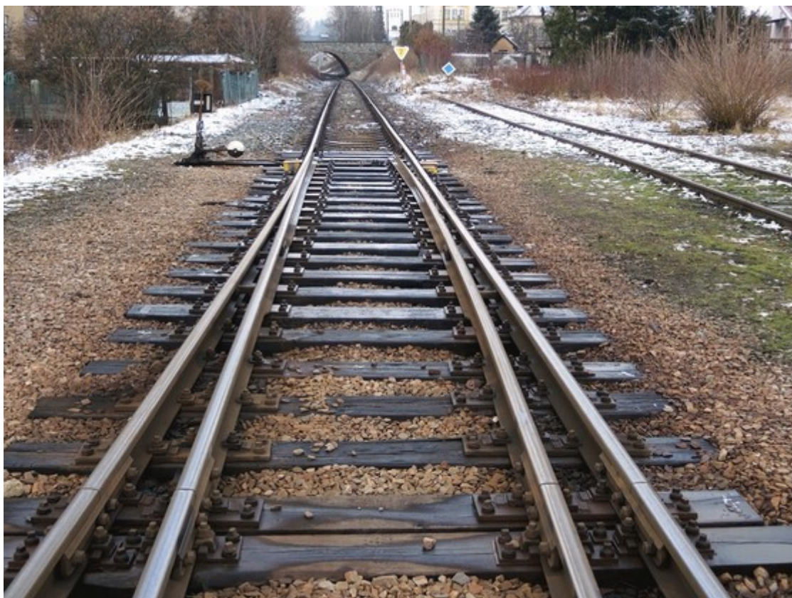
Obr. č. 1: Výhybka č. 8 ve směru jízdy vlaku Os 5034
