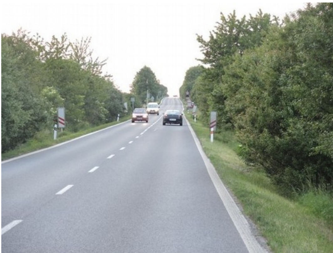
Obr. č. 3: Pohled ve směru jízdy motocyklu k železničnímu přejezdu P2104
