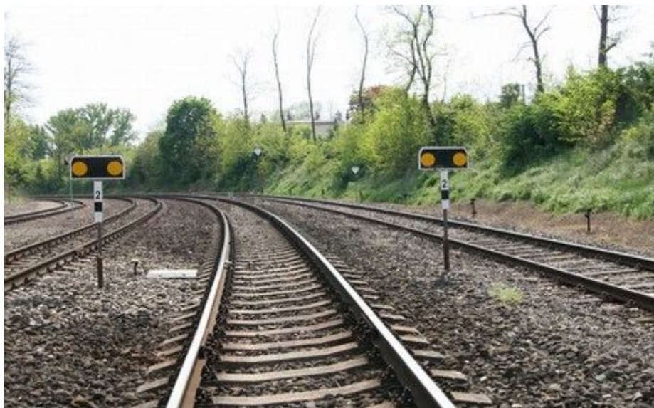
Obr. č. 3: Osazené přenosné přejezdníky
