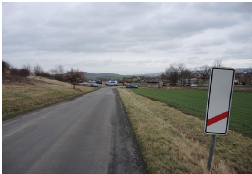
Obr. č. 4: Viditelnost výstražného kříže a výstrahy PZZ ve směru jízdy OA
