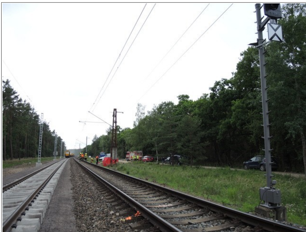
Obr. č. 2: Celkový pohled na místo vzniku MU ze směru od žst. Lysá n. L. Zdroj: DI
