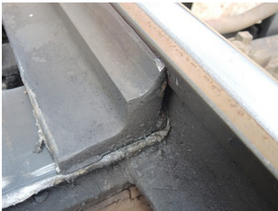
Obr. č. 2: Naražený hrot pravého vnějšího jazyka výhybky č. 25a Zdroj: DI
