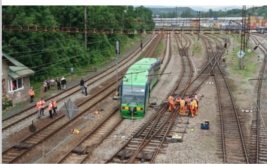
Zdroj: Dražní inspekce
