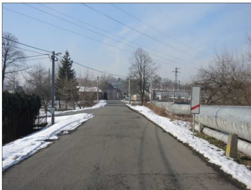
Obr. č. 3: Pohled ze vzdálenosti 90 m před ŽP P7724 na umístění svislé dopravní značky A 31c „Návěstní deska (80 m)“ a na ŽP, ze směru jízdy SMV. Zdroj: DI
