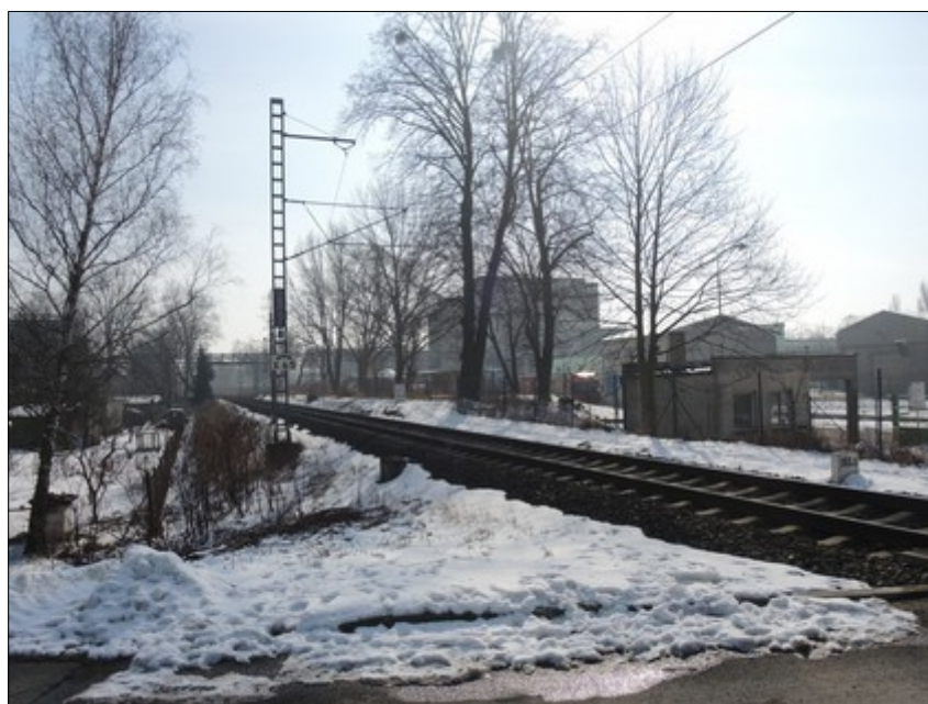
Obr. č. 6: Rozhled na trať ve směru přijíždějícího vlaku Os 3420 ze vzdálenosti 4 m od osy kolejí.
