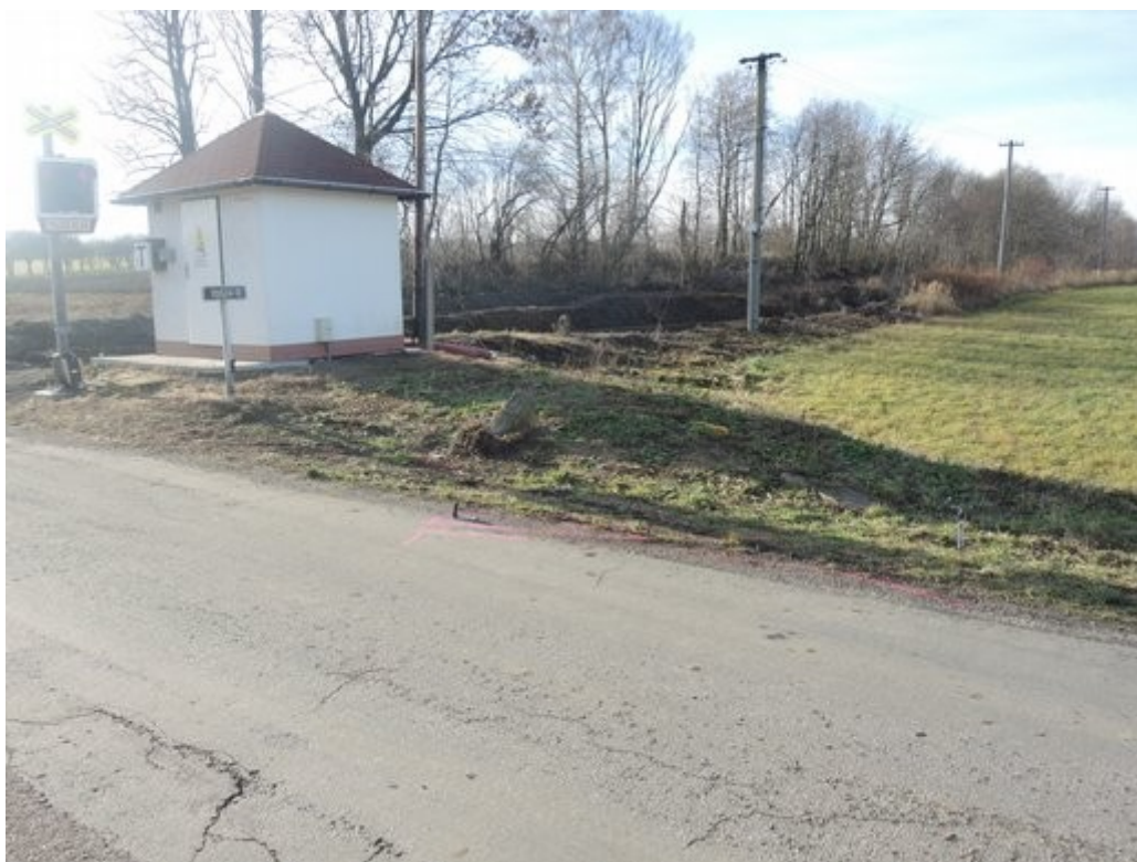
Obr. č. 6: Pohled z místa vyjetí OA směrem k výstražníku za technologickým domkem zabezpečovacího zařízení
