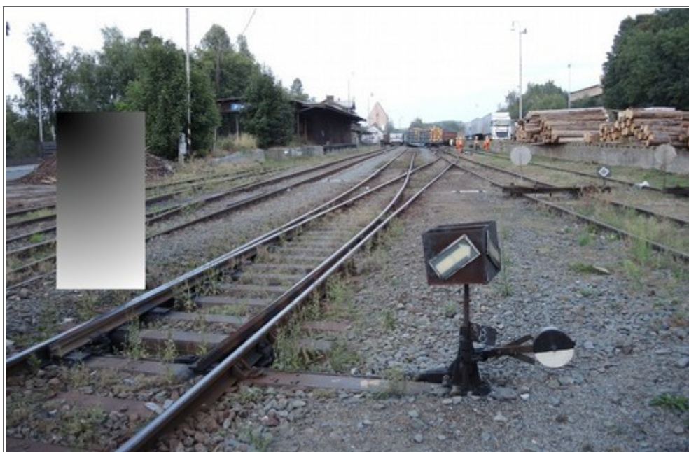
Obr. č. 5: Výhybka č. 8 dopravny D3 Rýmařov přestavená do polohy pro jízdu DV přímým směrem, tzn. ze SK č. 2b ve směru na vlečku KATR. Výhybkové návěstidlo návěstilo návěst „Jízda doprava“, tzn. nesprávně informovalo o směru jízdy přes výhybku proti hrotu vedlejším směrem doprava. V pozadí je viditelné vykolejené TDV D-NACCO 33 80 4742 044-7 v konečném postavení po MU.
