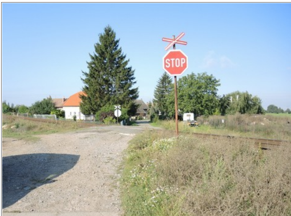
Obr. č. 3: Pohled na označení a zabezpečení ŽP P5391
