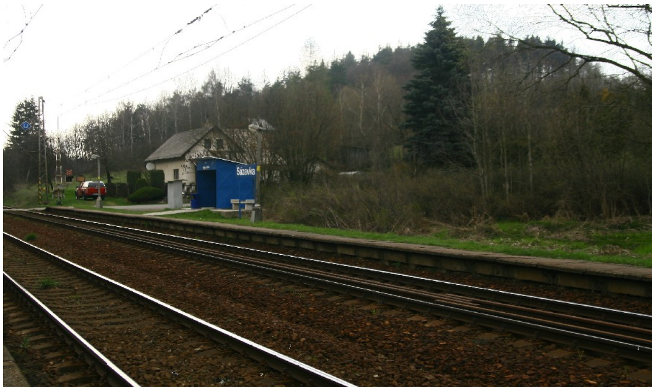
Foto 1: Nástupiště u 2. TK na zastávce Sázavka
