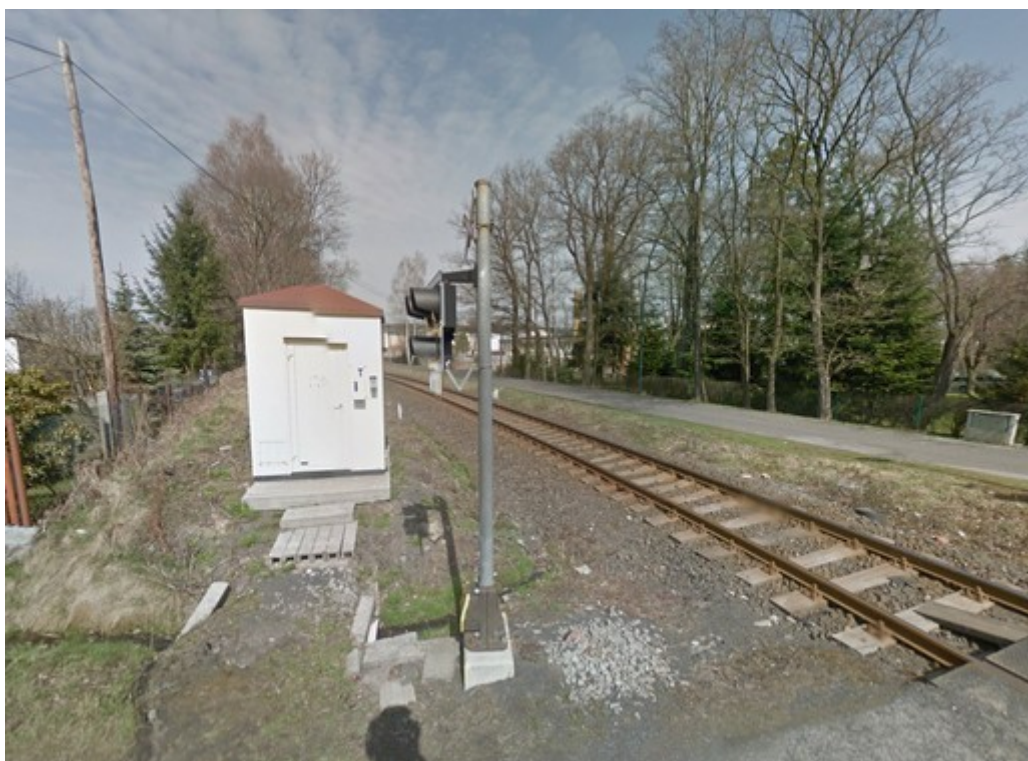
Obr. č. 4: Reléový domek situován ve vnitřní straně oblouku.
