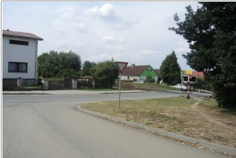
Obr. č. 3: Viditelnost výstražných křížů a výstrahy PZZ ve směru jízdy OA ze vzdálenosti 35 m
