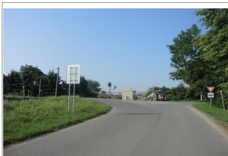
Obr. č. 5: Viditelnost výstražníku a výstrahy PZZ ze vzdálenosti 35 m ve směru jízdy OA
