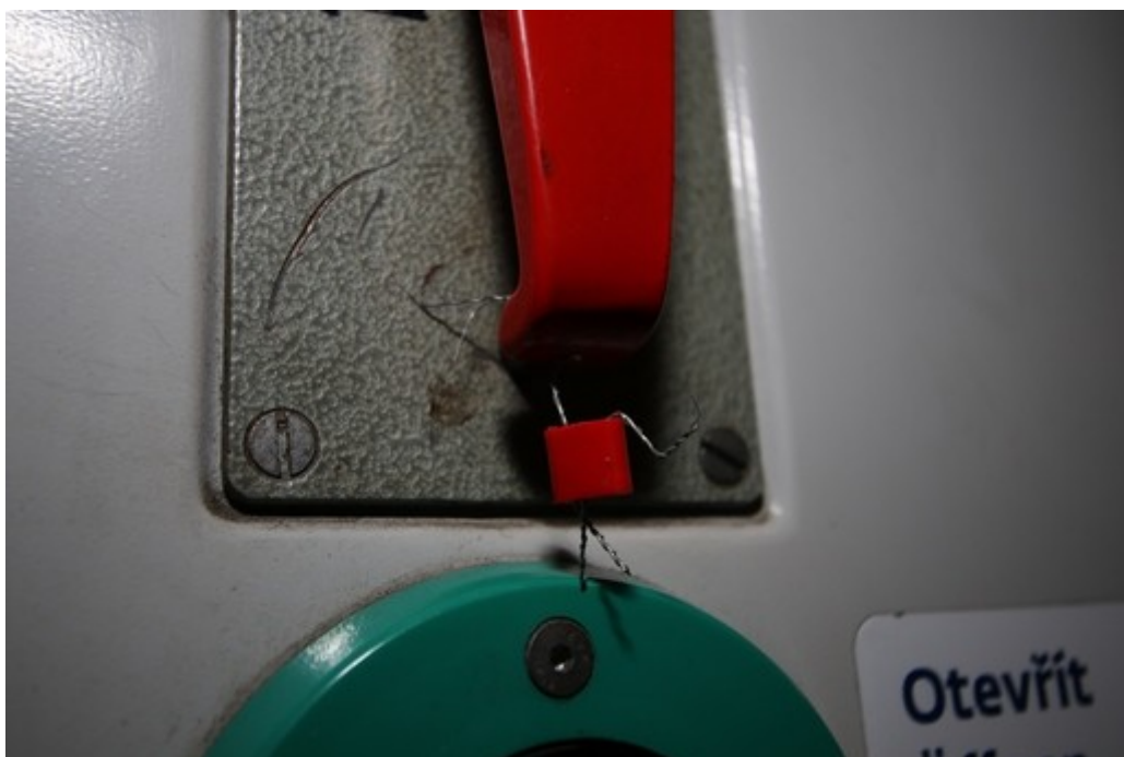
Obr. č. 6: Stržená plomba páky pro odblokování dveří na pozici 1L dotčených vznikem MU
