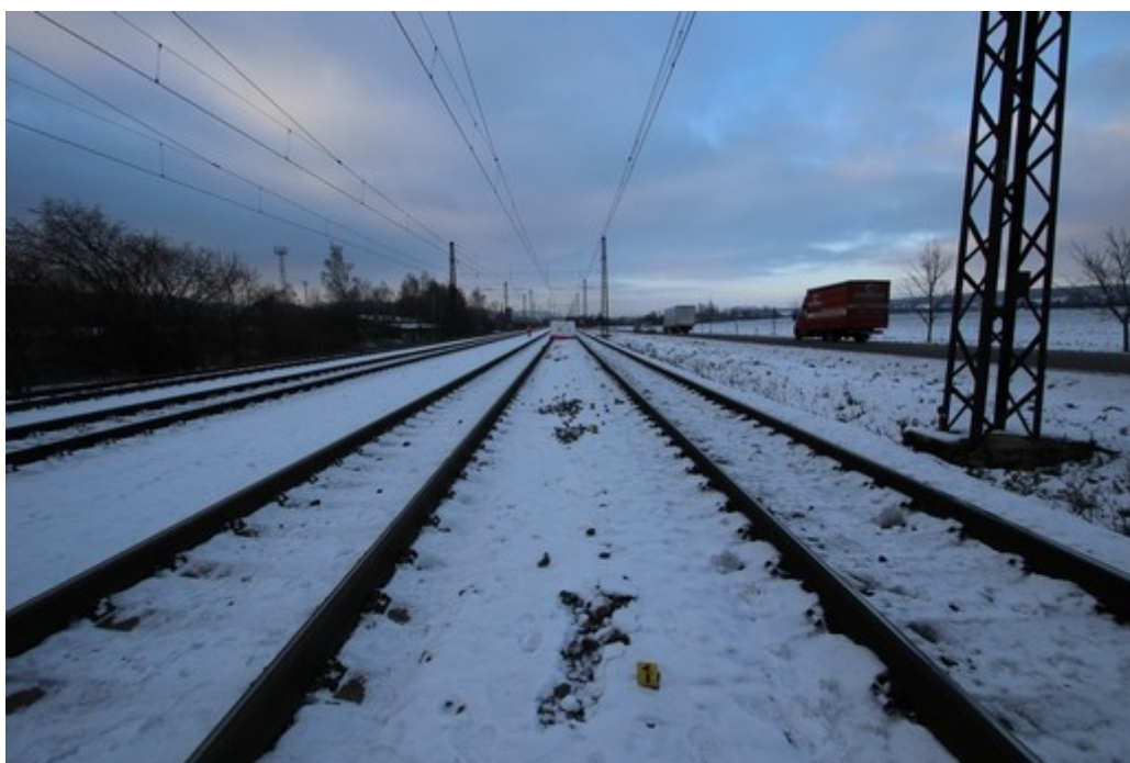
Obr. č. 7: Místo dopadu poškozeného mezi 1. a 2. TK
