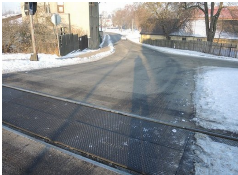
Obr. č. 4: Asfaltový povrch vozovky vedoucí k ŽP
