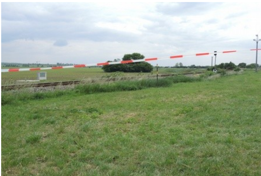
Obr. č. 5: Rozhled na trať před železničním přejezdem pro uživatele pozemní komunikace ve směru jízdy NA
