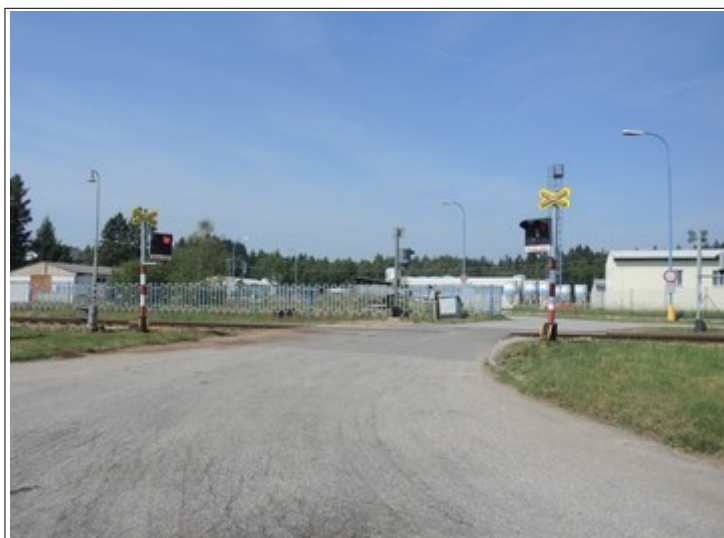
Obr. č. 3: Viditelnost výstražných křížů a výstrahy PZZ ve směru jízdy NA ze vzdálenosti 20 m Zdroj: DI
