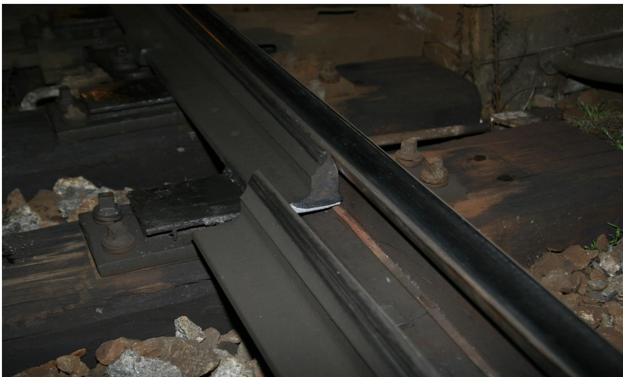
Obr. č. 6: Lom jazyka výh. č. 23 (část od hrotu jazyka)
