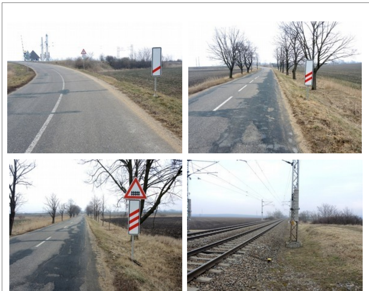
Obr. č. 5: Svislé dopravní značení před přejezdem ve směru jízdy OA a výhled řidiče ve směru jízdy vlaku.
