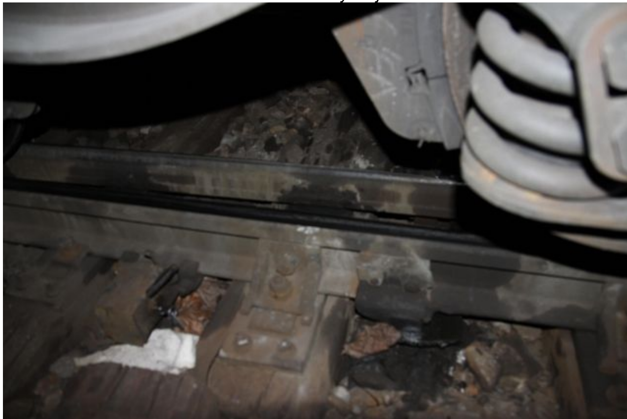
Foto 3: Pohled na výhybku
