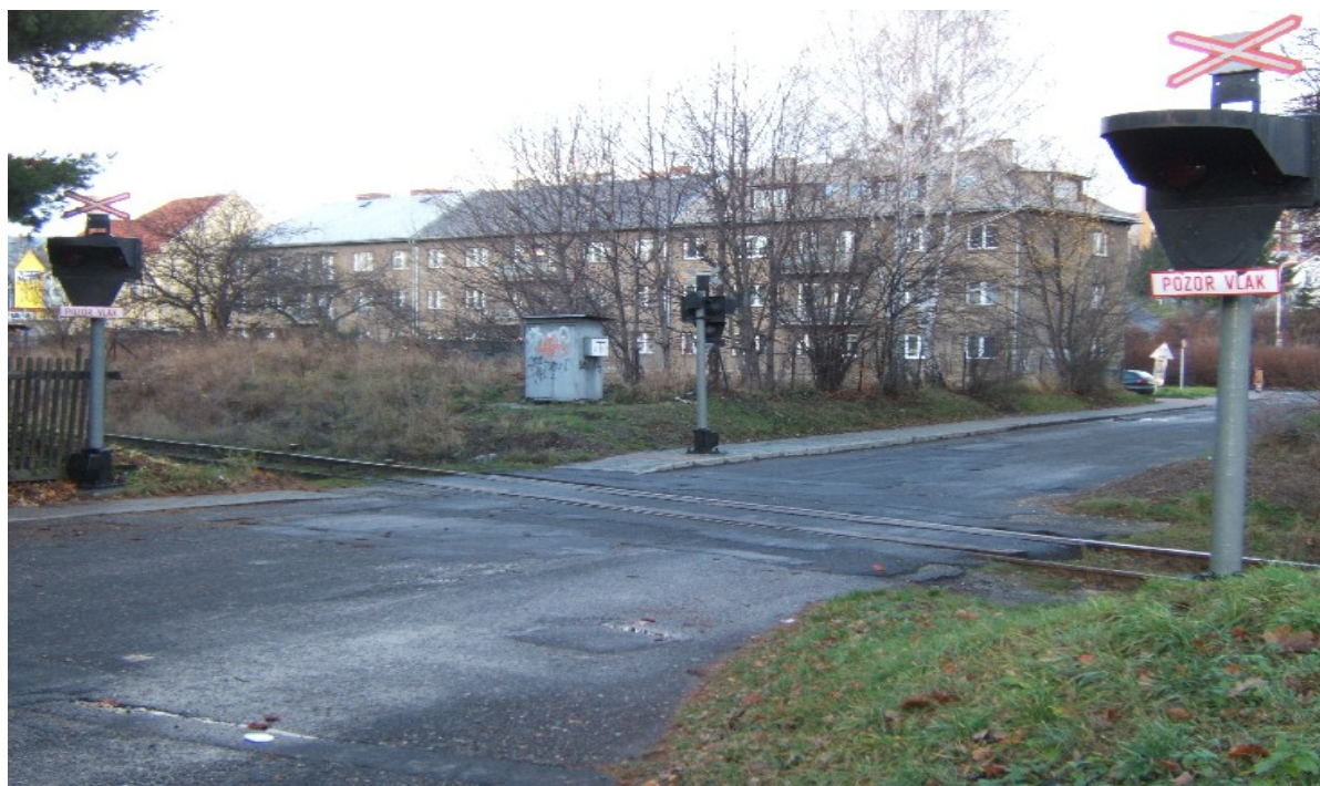
Foto 3: Pohled na železniční přejezd proti směru jízdy cyklisty
