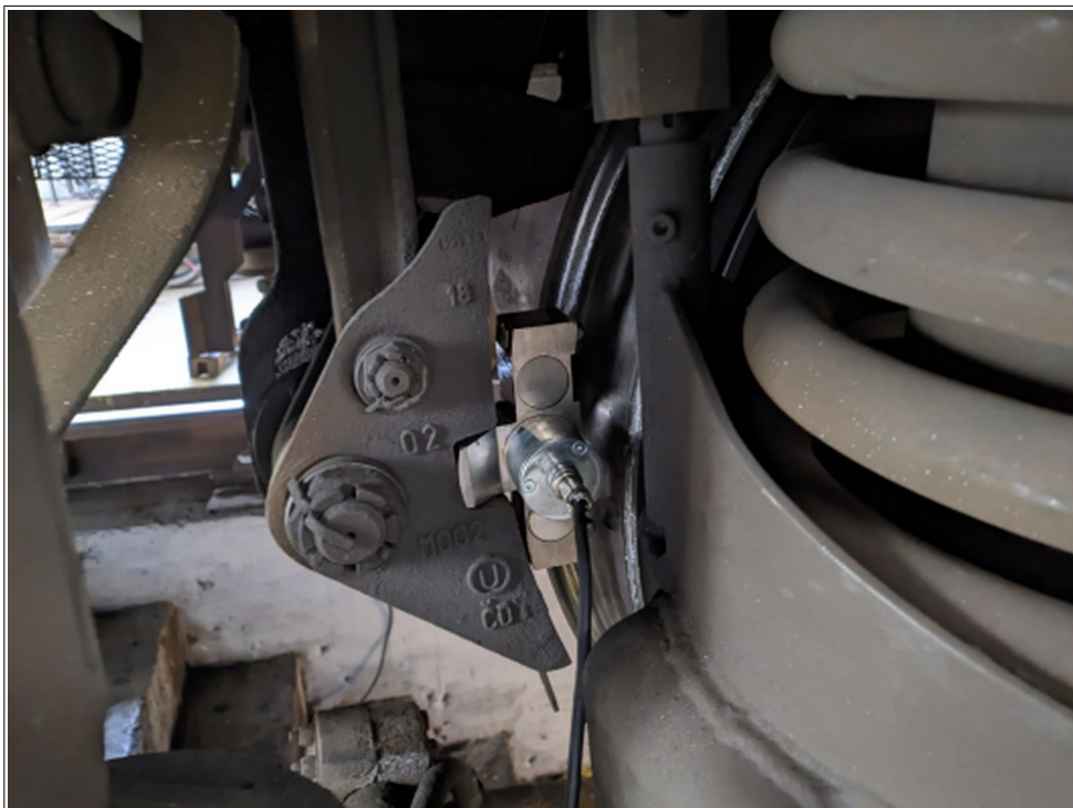
Obr. č. 6: Pohled na snímač síly (měrný špalík) použitý při měření přítlaku k jízdním plochám kol
