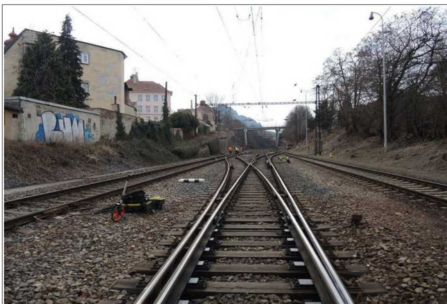
Obr. č. 2: Pohled na výhybky č. 35 a 37
