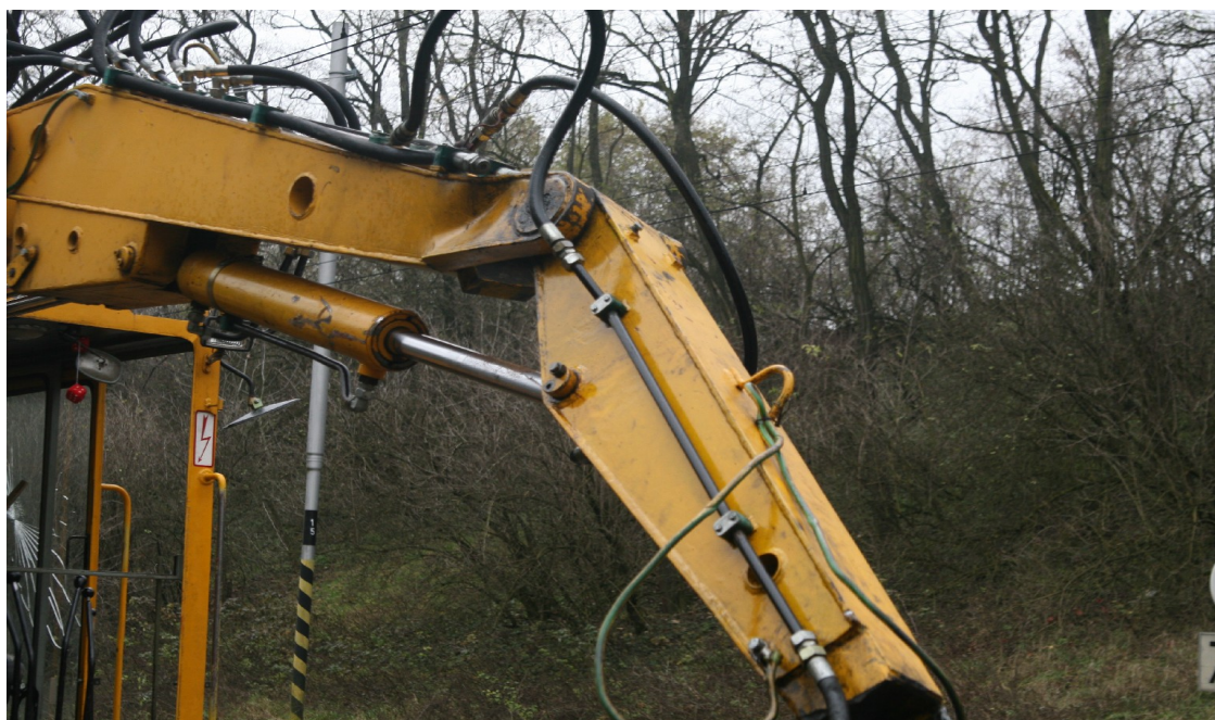
Foto 2: Poškozené rameno SHV SVP 74
