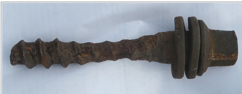
Obr. č. 3: Vrtule značně poškozená korozí po demontáži z dřevěného pražce DK č. 27 Zdroj: DI
