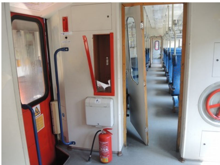
Obr. č. 5: Pohled na poškození interiéru DV vlaku Os 4615
