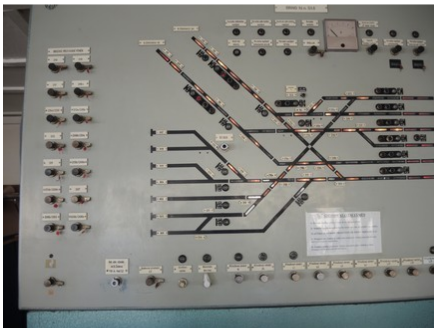
Obr. č. 3: Pohled na kolejový reliéf na St 6 po vzniku MU
