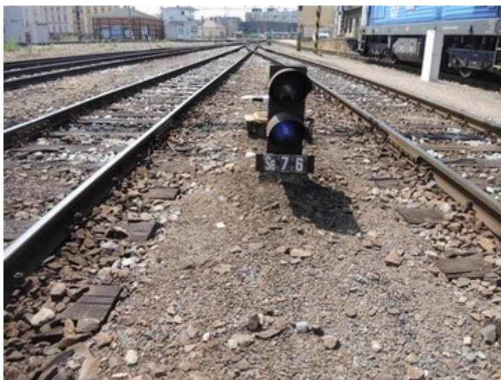
Obr. č. 4: Pohled na návěstidlo Se76
