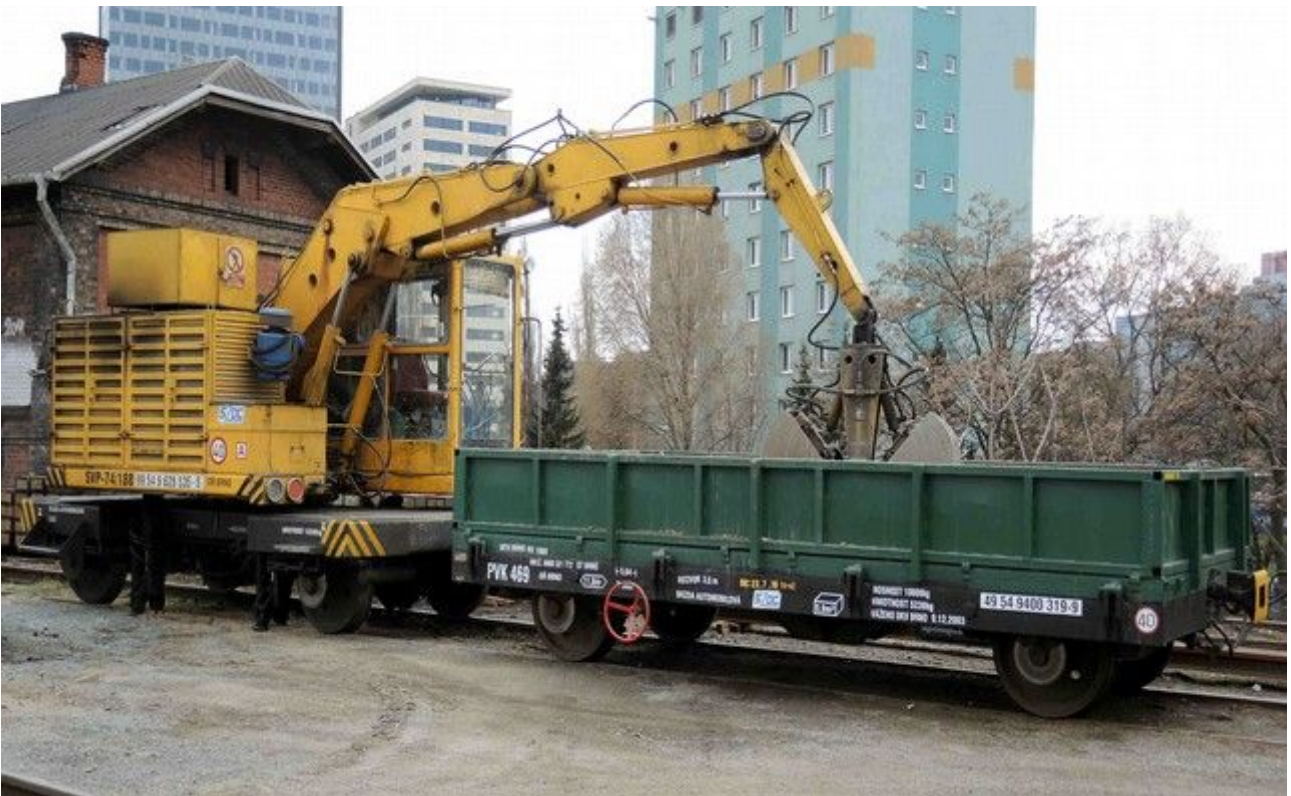
Obr. č. 8: Strojní vyťahovák pražců SVP-74 s přívěsným vozíkem
