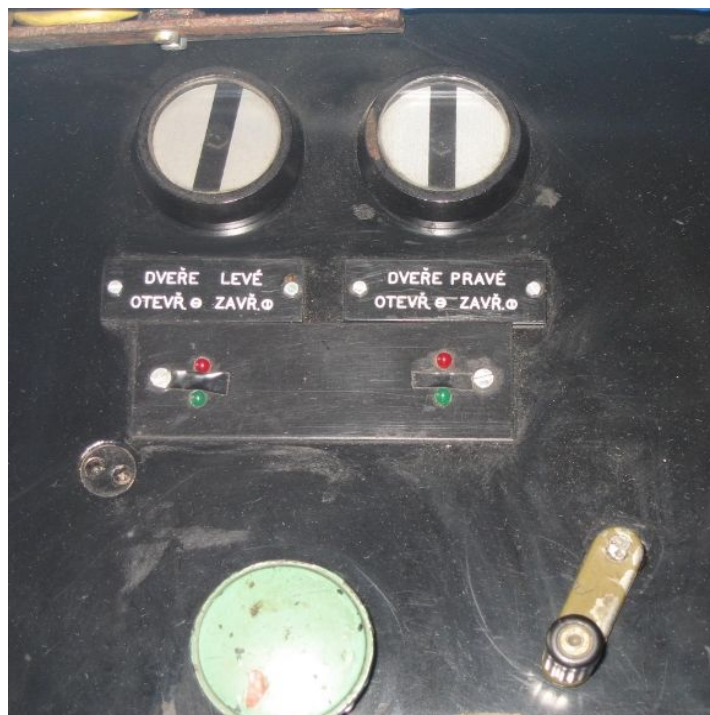
Obr. č. 7: Pohled na ukazatele stavu nástupních dveří na stanovišti HDV 460.075-5
