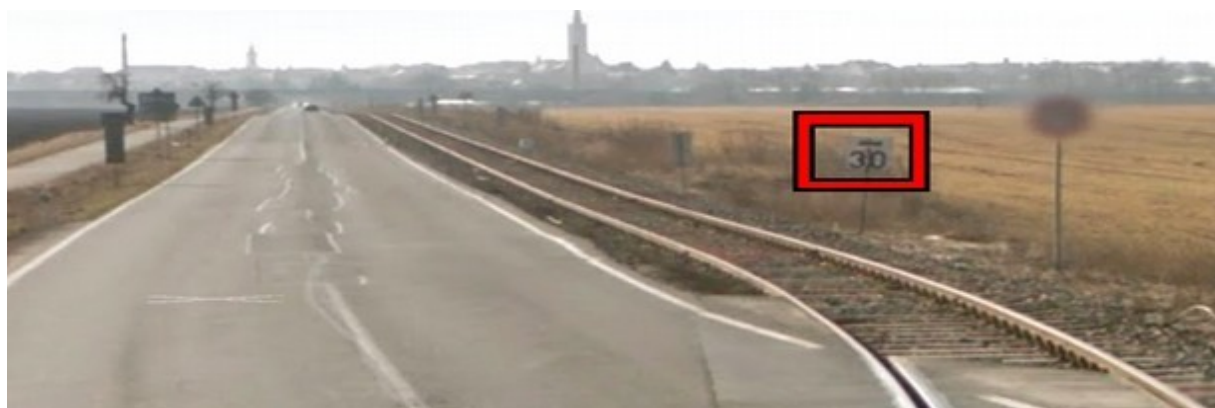
Obr. č. 9: Výhled na silnici a trať od ŽP P3737 směrem na Čáslav v březnu 2012 Zdroj: maps.google.com
