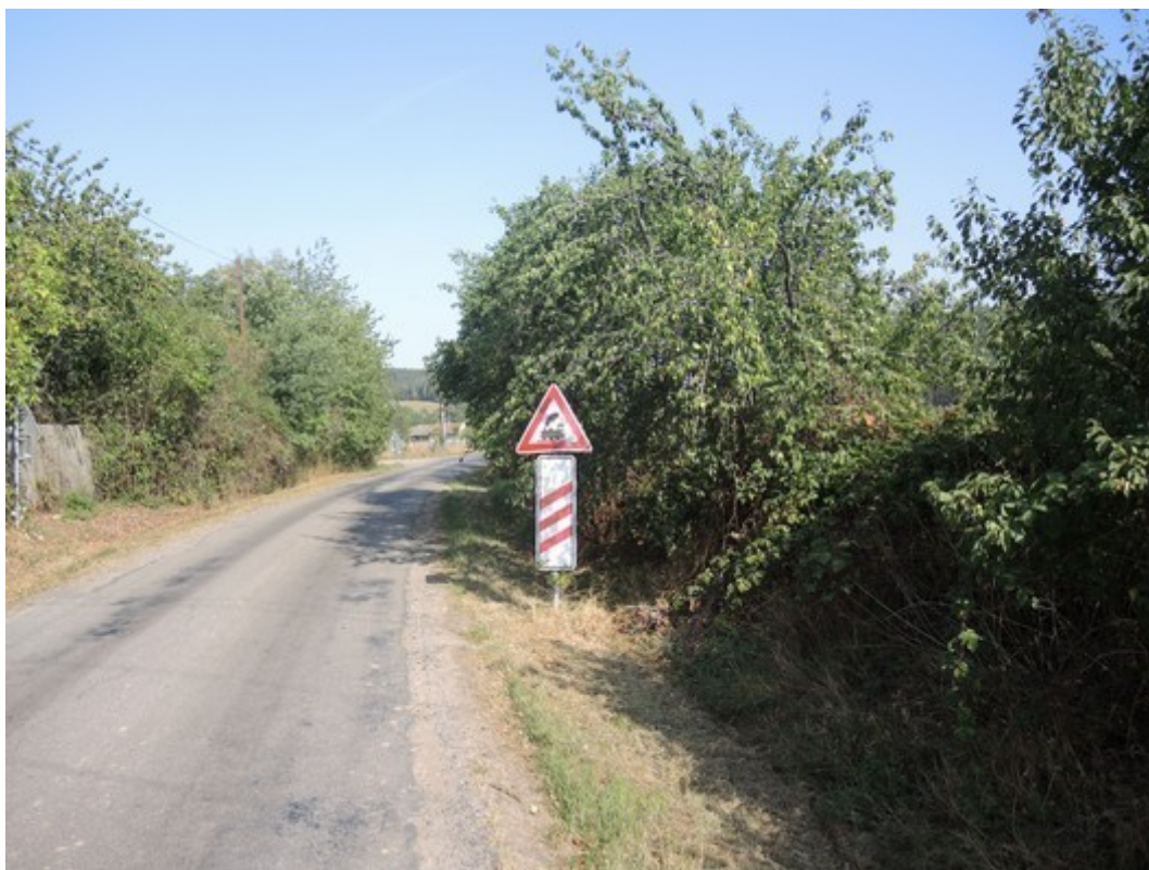
Obr. č. 11: Stav dopravních značek A 31a, A 30 ve směru od obce Prosetín po odstranění zeleně
