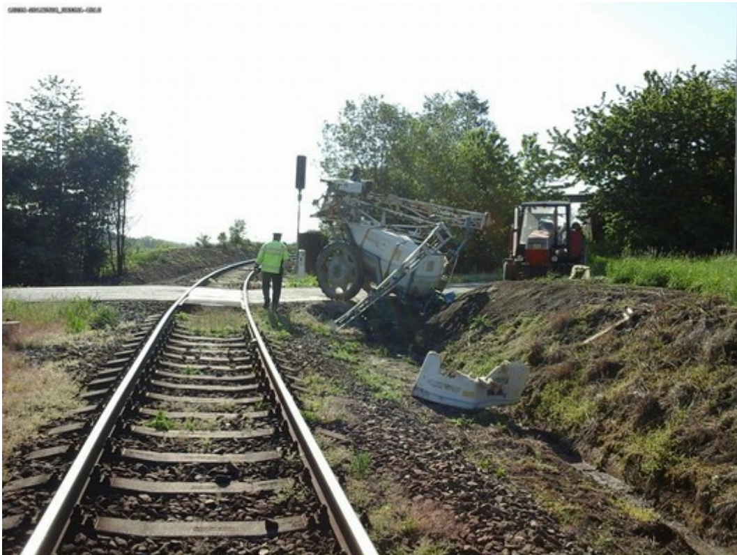
Obr. č. 5: Pohled na železniční přejezd ve směru výhybna Cejřov
