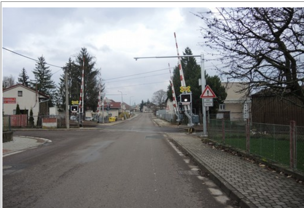
Obr. č. 6: PZZ se závorovými břevny z ulice Hradecká
