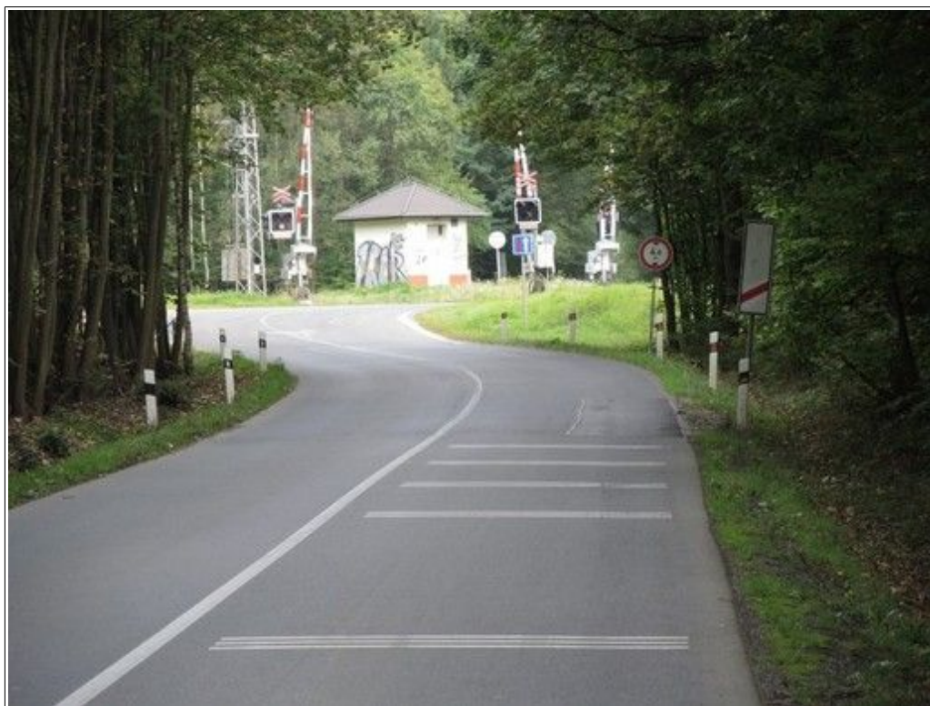
Obr. č. 5: Značení dopravními značkami ve směru jízdy OA
