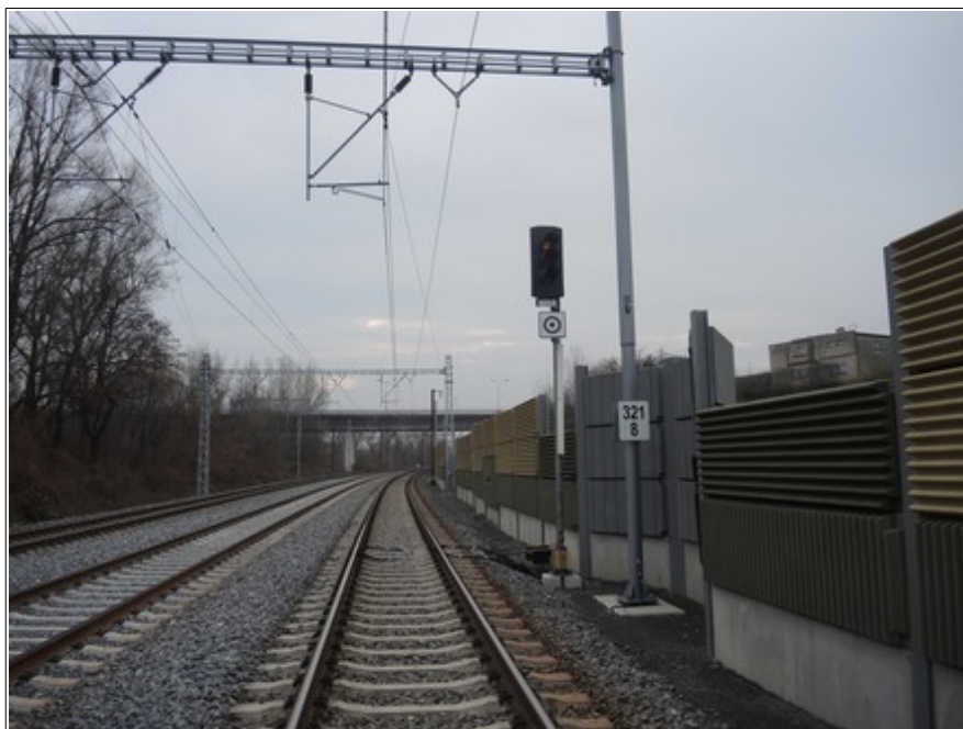
Obr. č. 3: Pohled na oddílové návěstidlo AB 1-3218 a protihlukovou stěnu nacházející se vpravo TK č. 1 odb. Chotěbuz – Český Těšín. Zdroj: DI
