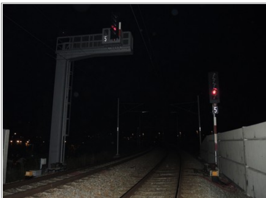
Obr. č. 1: Pohled na hlavní (vjezdové) návěstidlo 2L žst. Plzeň hlavní nádraží
