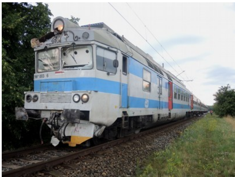
Obr. č. 10: Pohled na poškozené HDV
