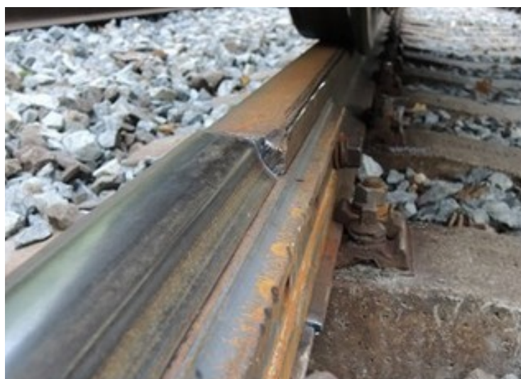
Obr. č. 4: Styk ojeté a nově vložené kolejnice
